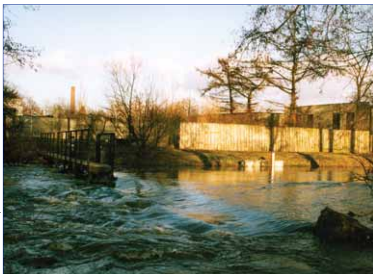
branie roztopowe w marcu 2005 r. [wodowskaz przy ujęciu wody – nie jest posterunkiem IMGW – nie obejmuje w takich warunkach całego przepływu; z lewej strony tuż poniżej jazu dopływają wody omijające jaz, przepływające przez naturalny polder u ujścia Okrzeszy do Pisi Gągolino, dopływ wód z polderu na zdjęciu po prawej stronie; przęśla płuczące jazu – na zdjęciu po lewej – w czasie wezbrania nie zostały otworzone (!)]
